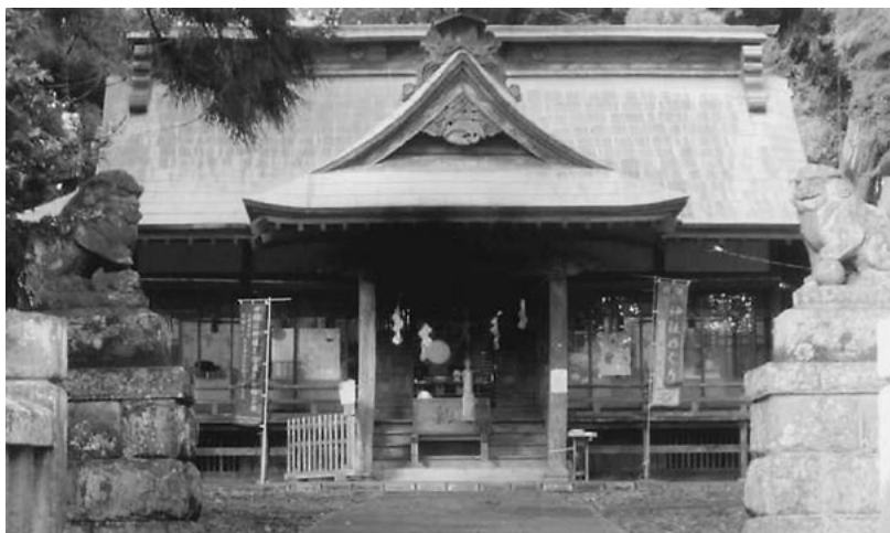
関戸神社全景 令和4年9月撮影
