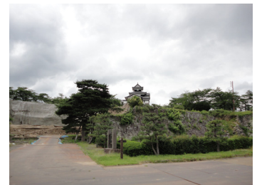
東日本大震災により穴太衆（あのをしゅう）によって積み上げられた石垣が崩落。現在天守閣は閉鎖中
