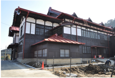
耐震工事中の共楽館
