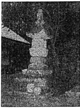
宝篋印塔（ほうき ょういんとう）の 相輪（最上部の棒 状の部分）が破断
